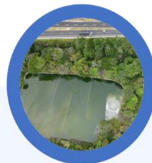
TRATAMIENTO DE AGUAS RESIDUALES
