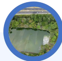
TRATAMIENTO DE AGUAS RESIDUALES
